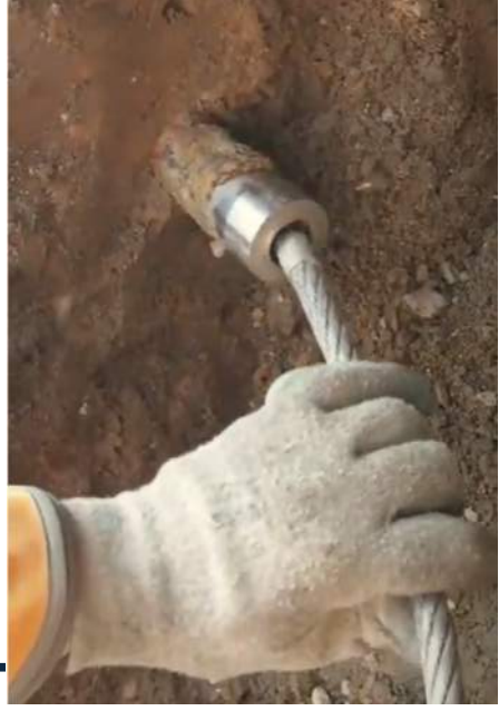
Trenchless (Pull through)
